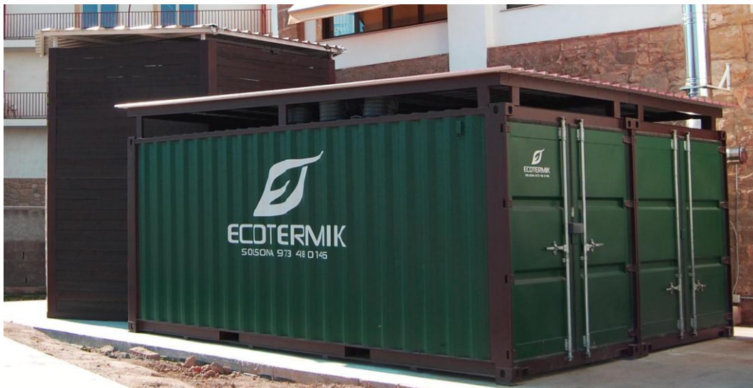
Imagen 28: Ejemplo equipo térmico en contenedor
