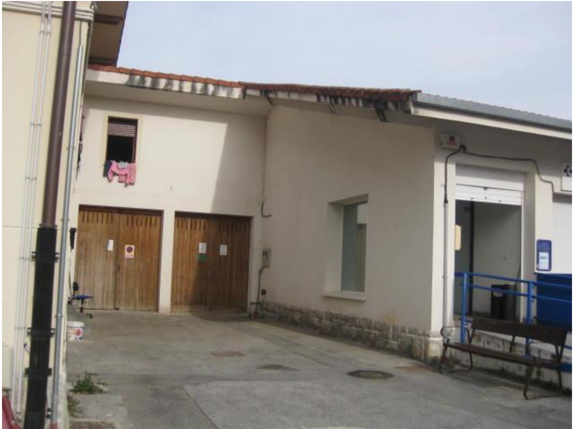
Imagen 19: Centro de salud. Fachada Sur
