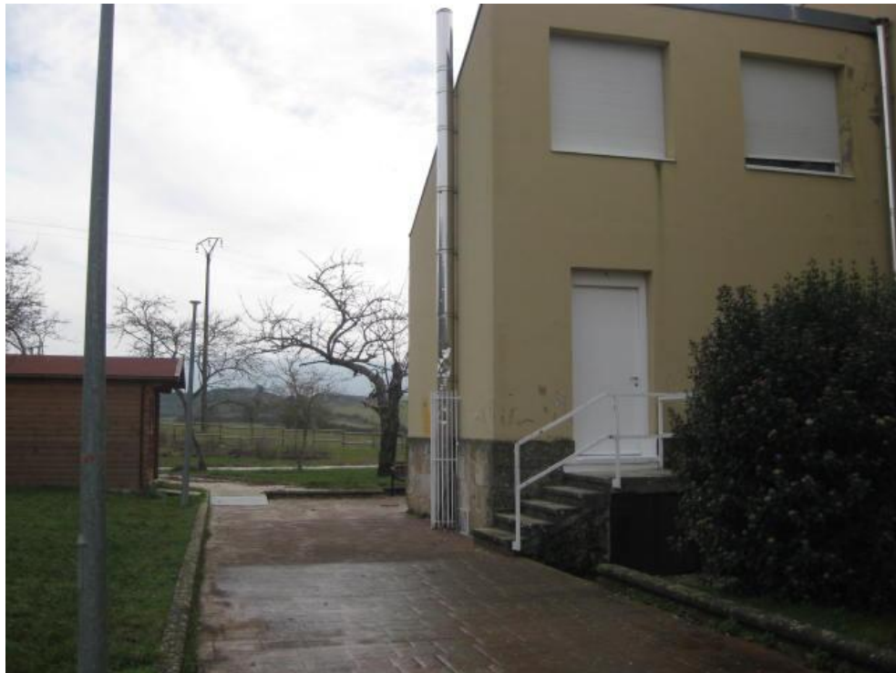
Imagen 15: Acceso sala de calderas Casa Cultura
