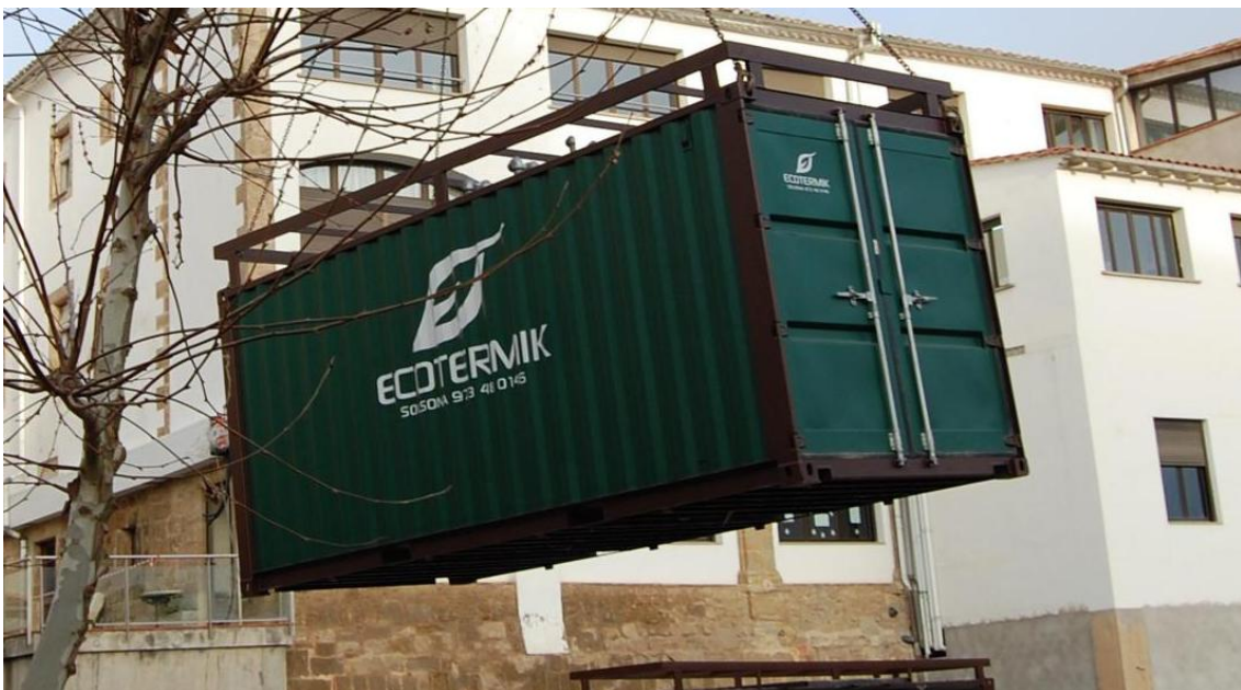
Imagen 26: Ejemplo equipo térmico en contenedor
