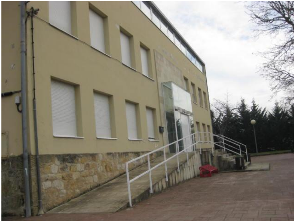
Imagen 10: Fachada Sur Casa Cultura
