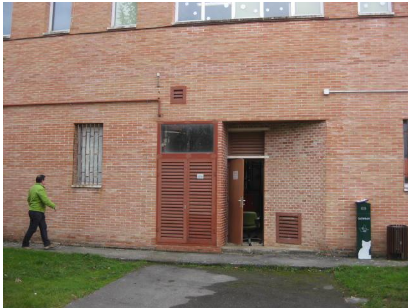
Imagen 3: Acceso sala calderas colegio
