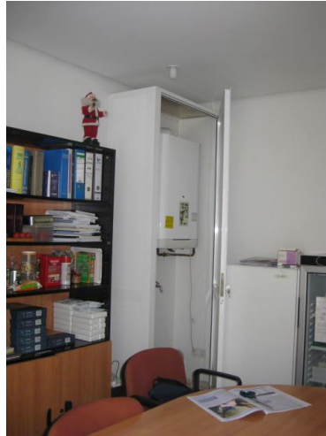
Imagen 25: Centro de salud. Caldera
