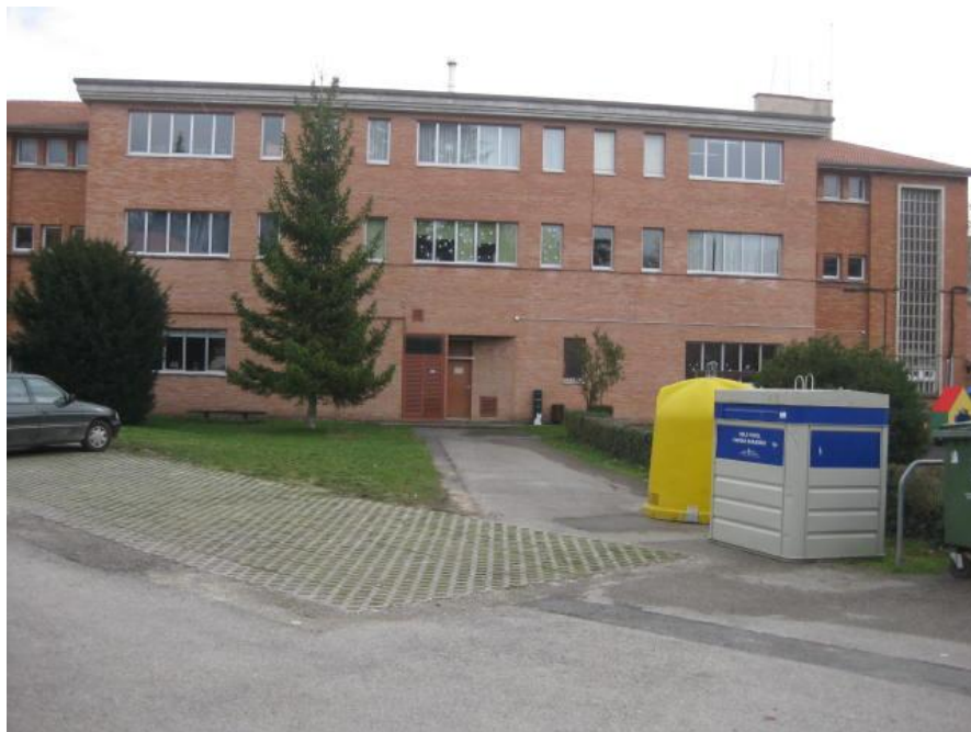
Imagen 4: Fachada Oeste colegio.
