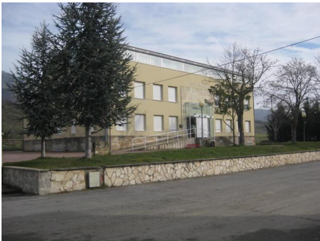
Imagen 11: Fachada Sur Casa Cultura
